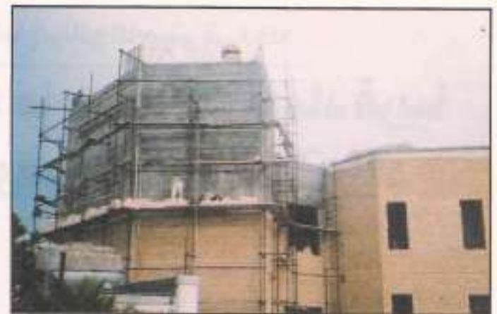
● المبني الجديد أثناء البناء
