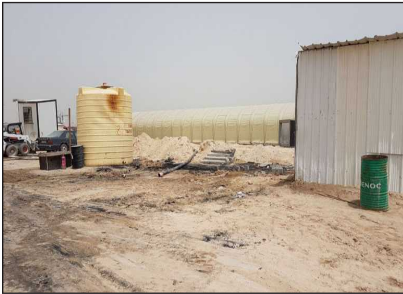
آثار الحريق على خزان المياه
