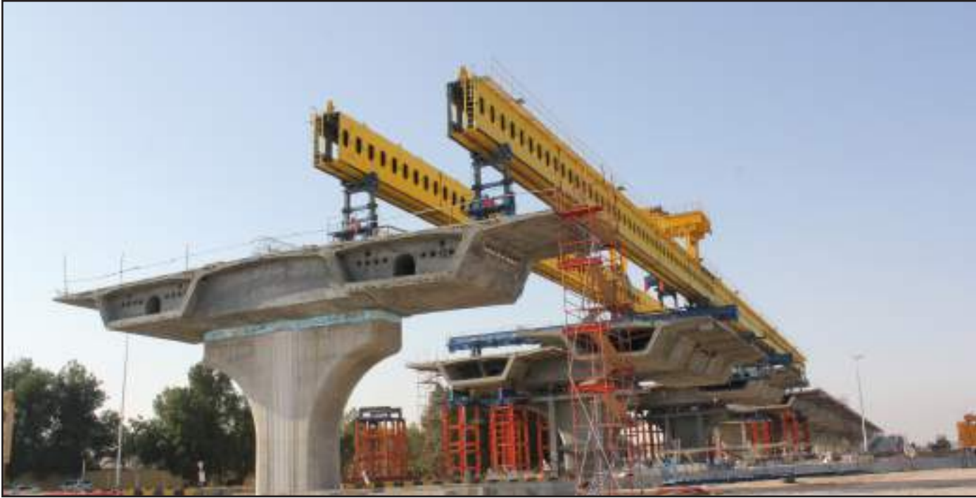
● تركيب قطع الجسور بالونش المعلق
