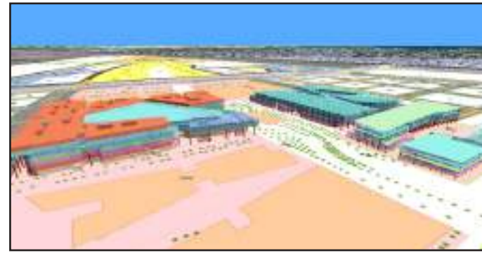
● جانب من المباني
