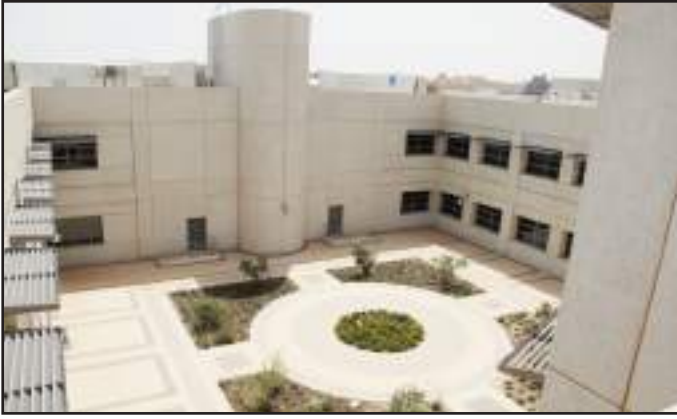
● جانب من المبنى
