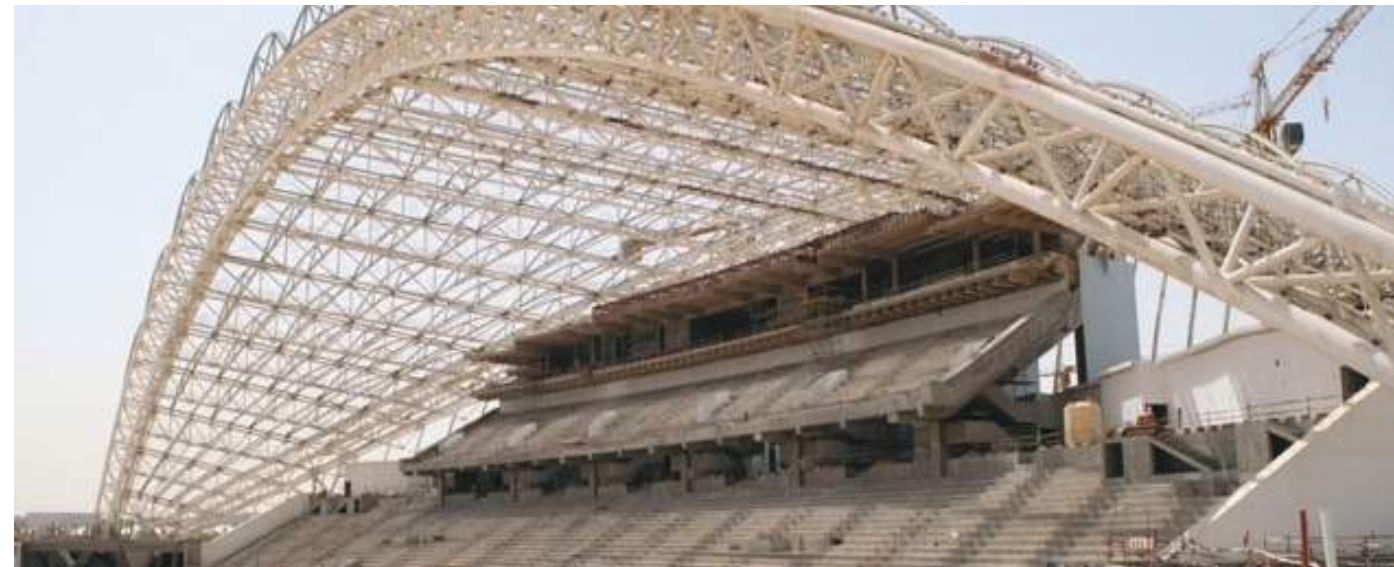
إحدى المنشآت الرياضية
