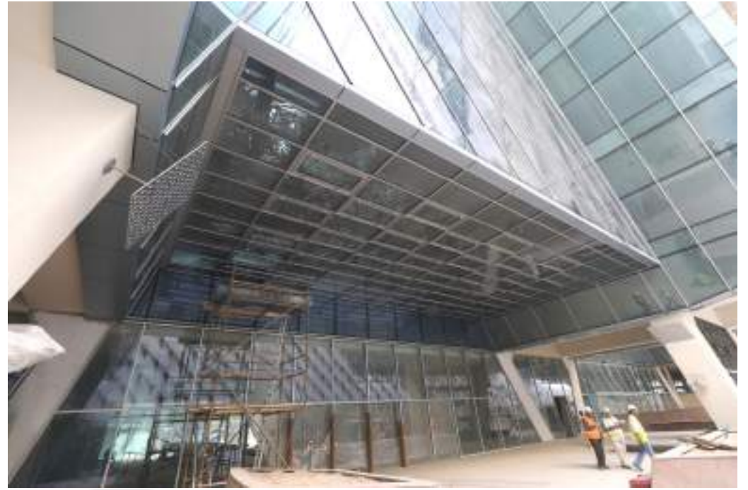
• المدخل الغربي في مبنى البنات
