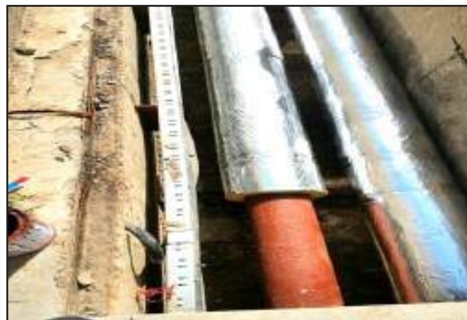
● استبدال عوازل الحرارة القديمة لأنابيب المياه في كيفان
