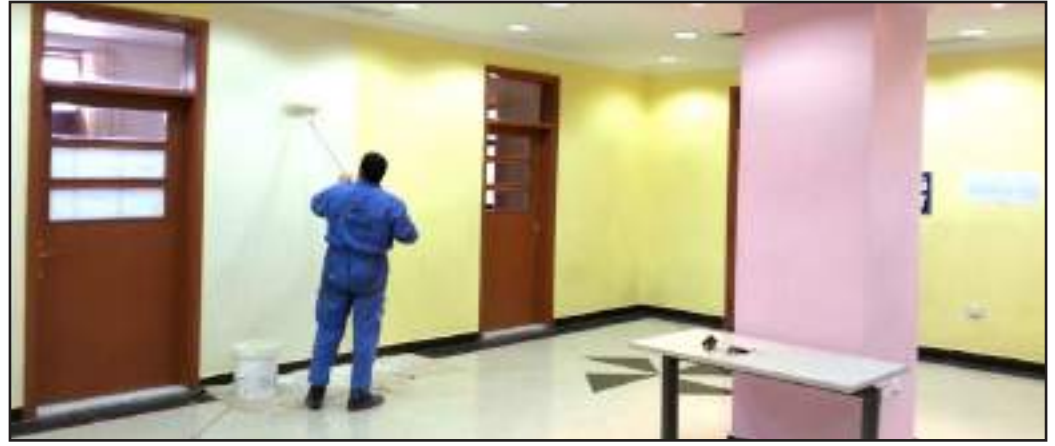
● أعمال الصبغ في مبنى ٩ الشويخ
