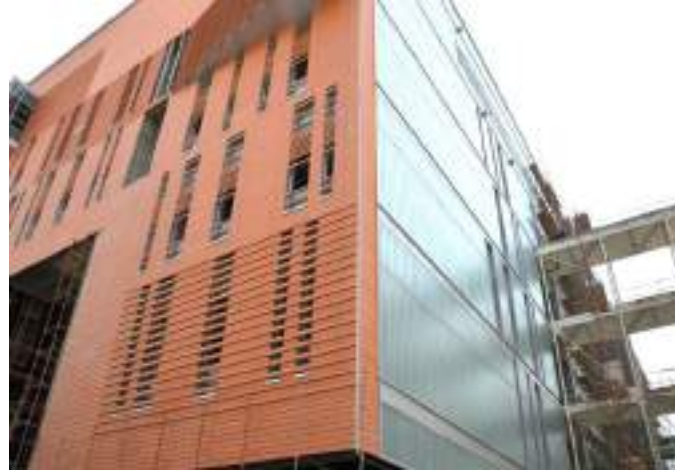
● الواجهة الخارجية لمبنى الكلية
