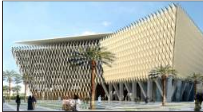
● المبنى من الخارج
