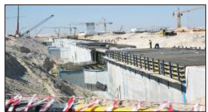
● تشييد نفق الخدمات
